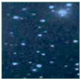
Pinholes in thick layer Epoxy primer
